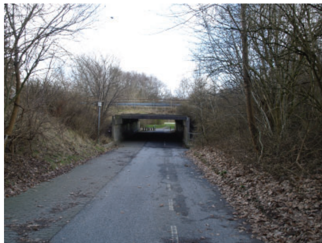
Tunnel for bløde trafikanter under Ny Gjellerupvej
